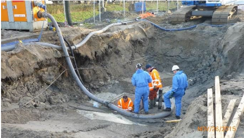
Foto: aanbrengen riolering George Stephensonweg
